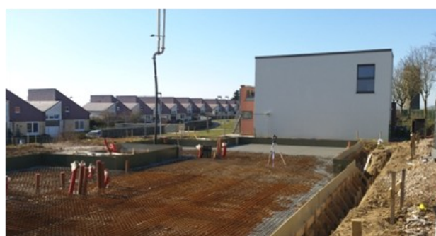
GEMECHENNE Construction de 4 logements
